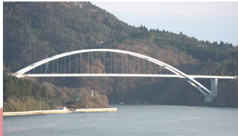
社会基盤構造物の例: 気仙沼大島大橋
